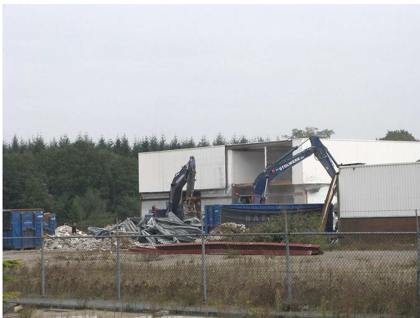
De overkapping van de oven valt onder de slopershamer.
