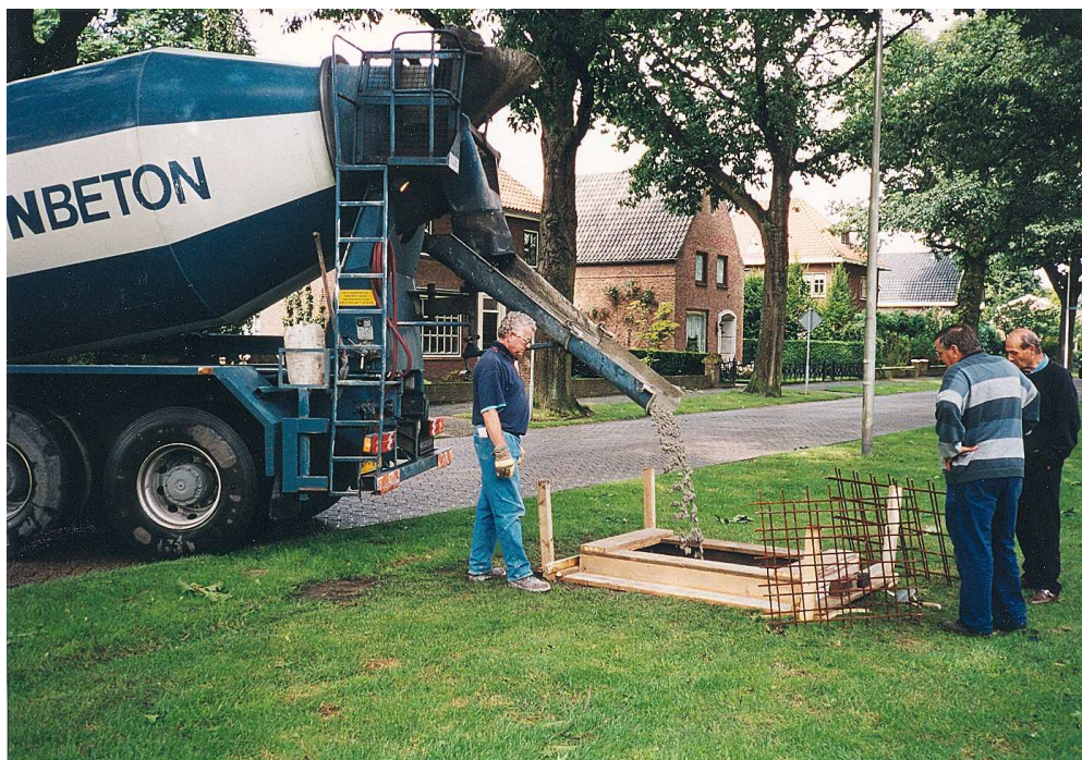
Beton er in en krimpnetten tegen het scheuren. Het wachten is nu op het kunstwerk.
