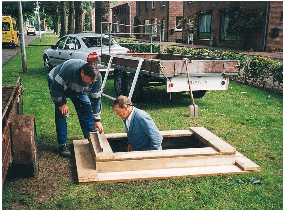
De bekisting zit er in en het waterpas wordt er nog eens op gelegd om te zien of alle klopt!
